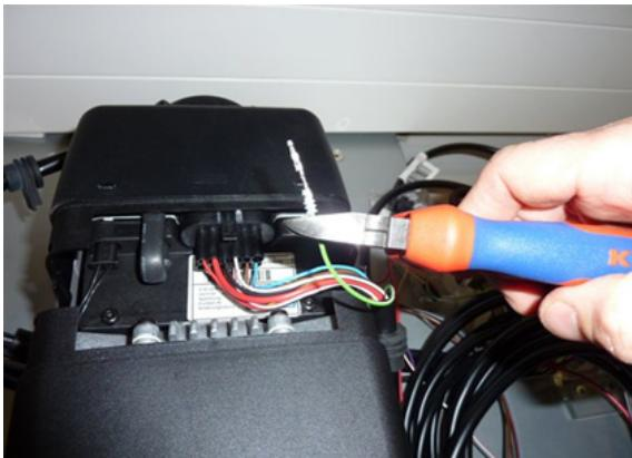
1. Koble strømforsyningen av varmeren (ta ut sikring)
